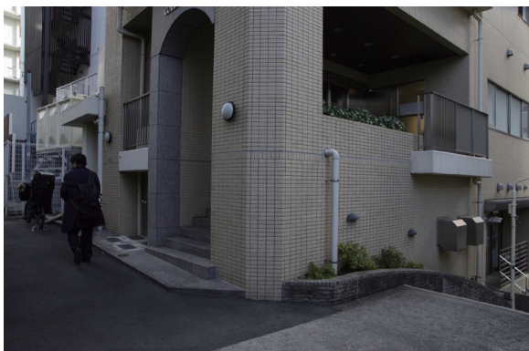
07 事務所へはこちらの入り口から階段を上がります。
